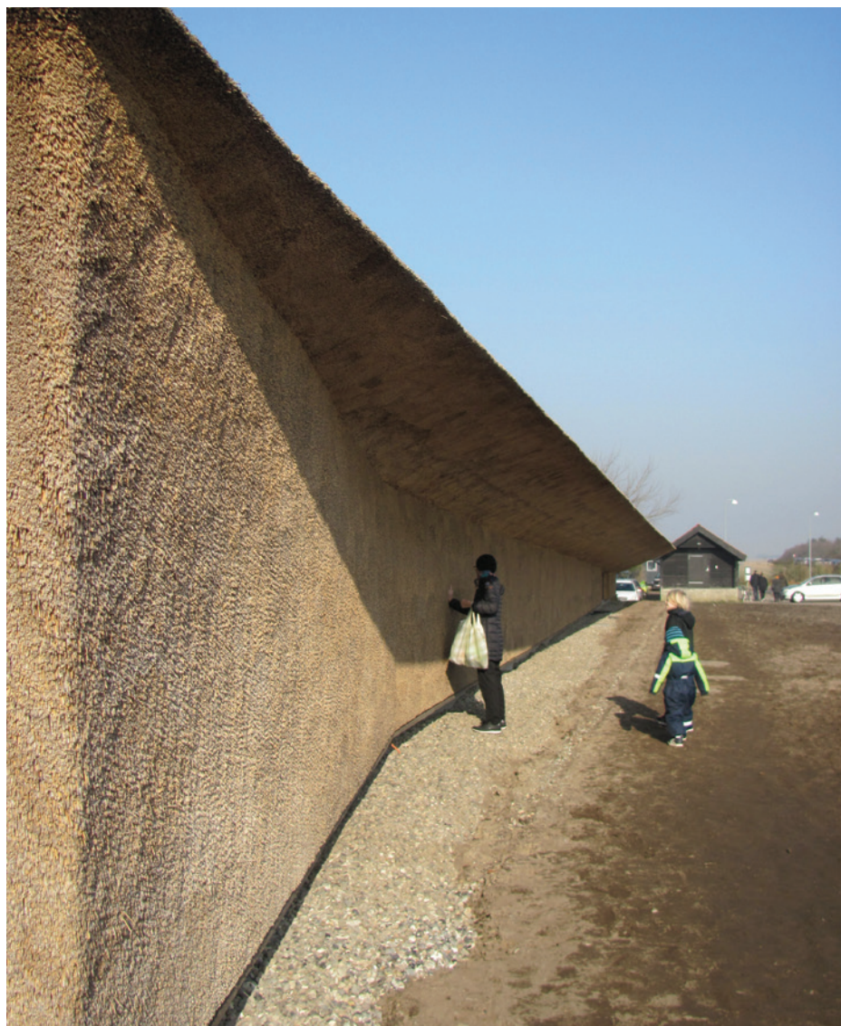
Tagrør er byggemateriale, også som vægge i Vadehavscentret
