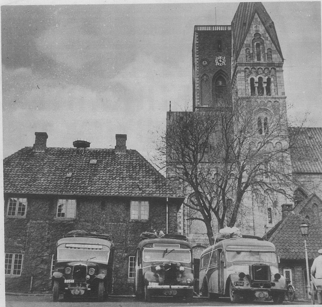
RIBES ÆLDSTE BINDINGSVÆRKSHUS , Domkirkens tidligere Kapellanbolig, Hans Tavsens Hus, der er opført i to Etag'er, anvendes i Dag som — Rutebilstation.
